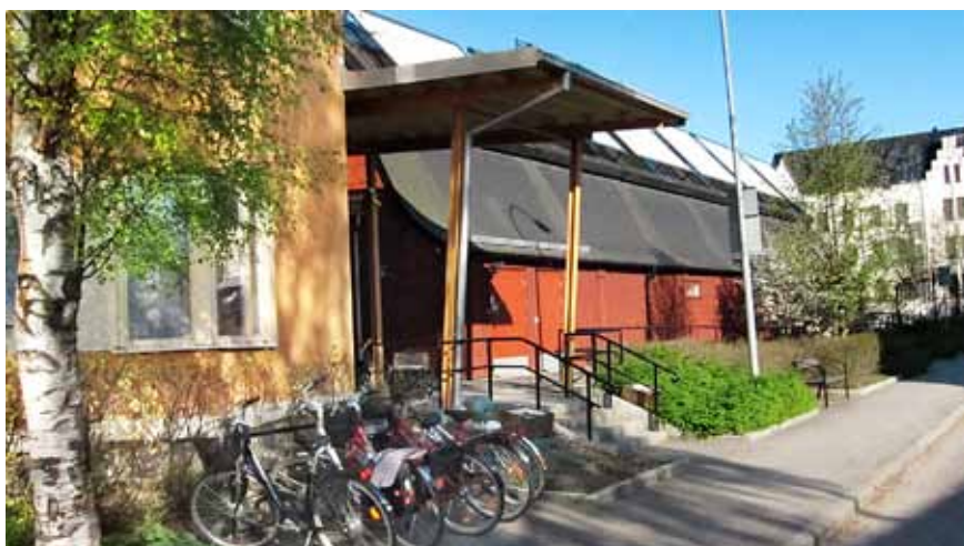
Trappa (till vänster) och ramp (till höger) upp mot huvudentrén. Grönt och välvårdat. En bänk att invänta taxin på.
