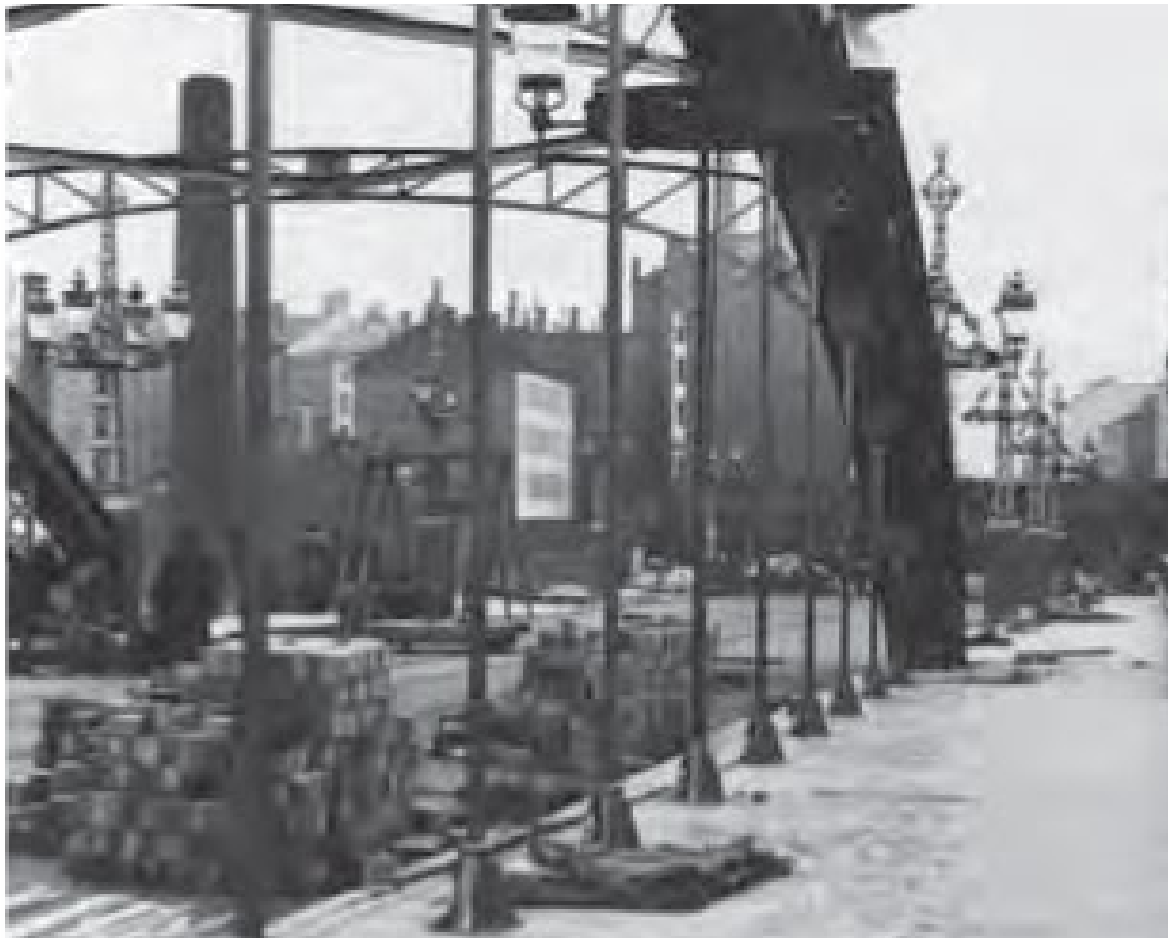
Bild 5. Inget nytt under solen - bullerhistorisk kuriosita. År 1906 ersatte man kullerstensbeläggningen på S:t Eriksbron i Stockholm med impregnerad träkubb för att dämpa bullret från hästhovar och stålklädda hjul. Det fungerade, men kostade mer och höll kortare tid. Alltså samma problem då som nu!
