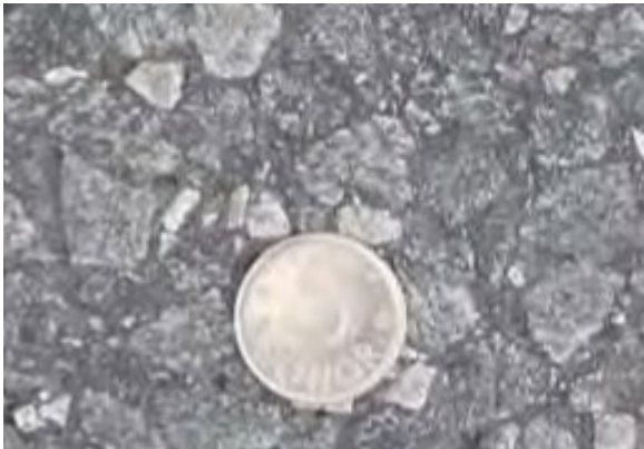
Bild 3. Stenrik asfaltbetong, ABS. Vägyta.
