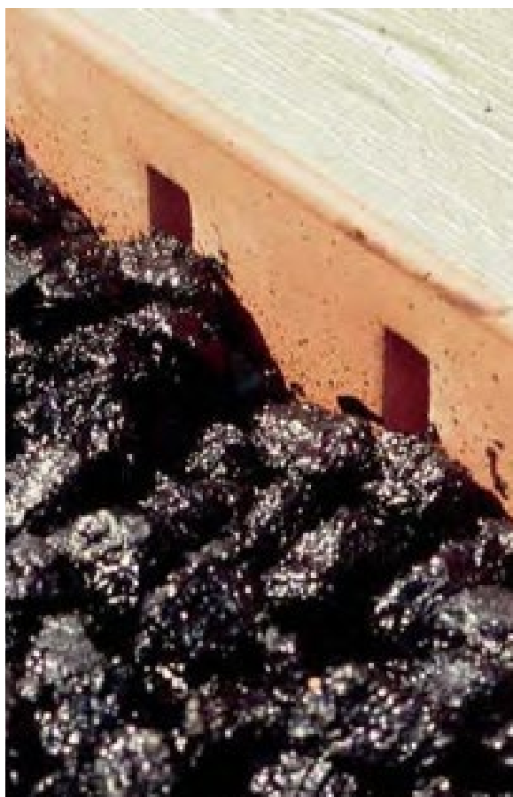
Bild 13. Större åtgärd för att leda bort vatten genom perforerade rör till en dagvattenbrunn. Foto: Bilden är hämtade ur Bendtsen rapport nr 4, se Lästips.
