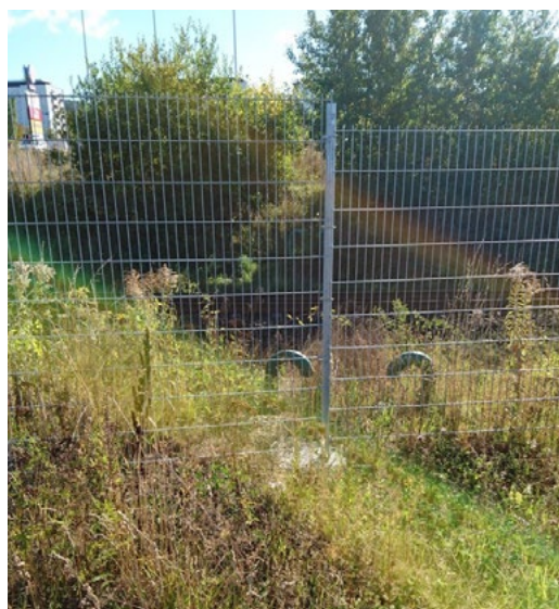
Bild 21. Samma järnväg år 2016. Efter att det nya svårforcerade stängslet sattes upp är den tidigare stigen helt igenväxt. Källa: Jönköpings kommun.
