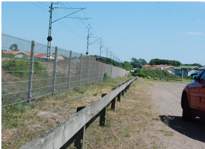
Bild 24. Stängsel längs järnvägen. Källa: Varbergs kommun.
