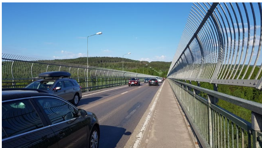
Bild 3. Ett exempel på konstruktion av broräcke med inåtböjd kurva i toppen för att försvåra överklättring. Alnöbron, Sundsvall. Källa: Sundsvalls kommun.
