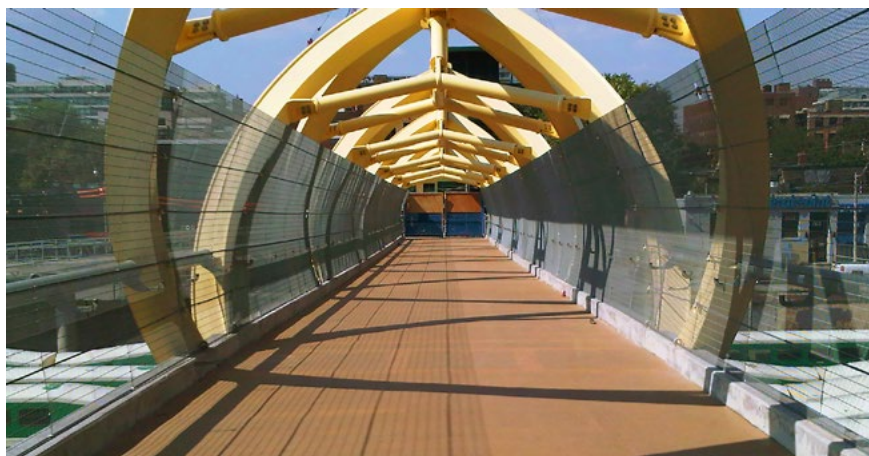
Bild 6. Böjt hårdat glas integrerat med stängselelement. Ljusinsläpp och utsikt bibehålls. Källa: www.clearvu.com .
